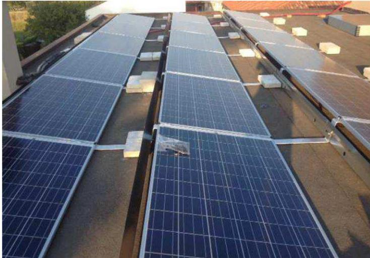
Il modulo fotovoltaico di cui si propone la posa avrà caratteristiche di resistenza al fuoco almeno pari a classe 2 o equivalente. Si riporta l'estratto delle prestazioni del modulo selezionato:
